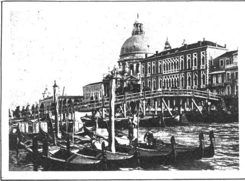
Con motivo de las grandes inundaciones que tuvieron lugar recientemente—¡oh paradoja!—en Venecia, se ha prohibido el tránsito por algunos de los históricos puentes de la ciudad de los canales, para que éstos puedan resistir mejor a la presión del agua, cuyo nivel supera, en mucho, el normal. Por ello han tenido que construirse puentes provisionales, de madera, como el que se ve en esta fotografía, y que han contribuido a variar el aspecto de algunas de las famosas perspectivas de la capital de los Dux.
